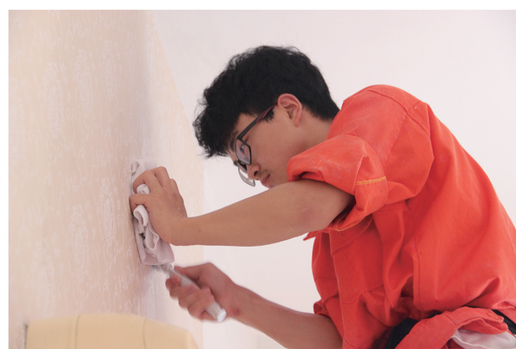
图为学生在小高家中进行房间改造
