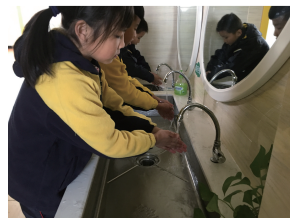
近段时间以来,随着天气越来越冷,洗手成了孩子们“发愁”的事情。桐乡市濮院茅盾实验小学及时在教学楼各个楼层安装了热水器,让孩子们能用温水洗手。(本报通讯员 王渊 摄)
